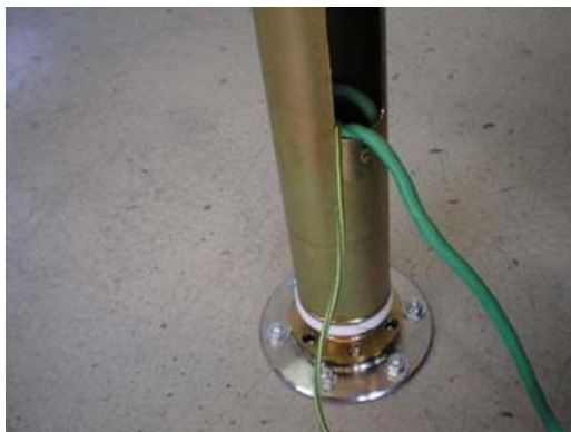
Рисунок 9 - Установка корпуса привода на напольный фланец
