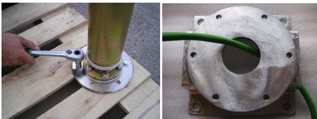
Рисунок 6 - Снятие турникета с паллеты
