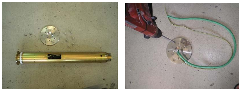
Рисунок 7 - Крепление напольного фланца турникета к полу
