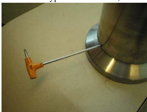
Рисунок 16 - Фиксация корпуса турникета
