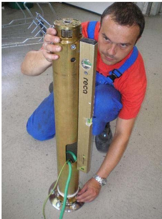
Рисунок 10 - Регулировка корпуса привода
