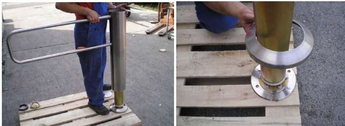
Рисунок 5 - Снятие напольной розетки
